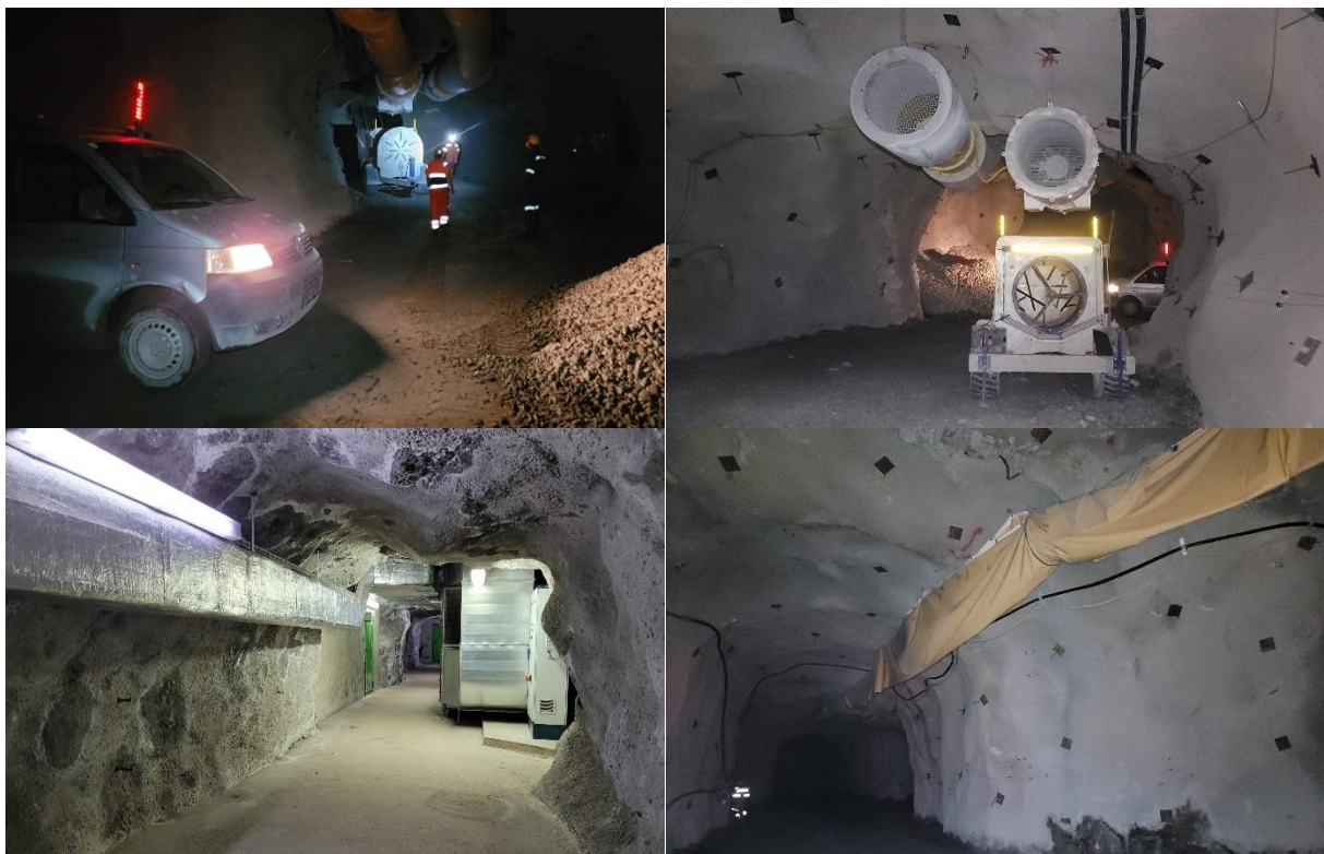
Abbildung 12 Darstellung der Gebläse, Lüftungsschächte und -schläuche verschiedener künstlicher Bewetterungsanlagen
