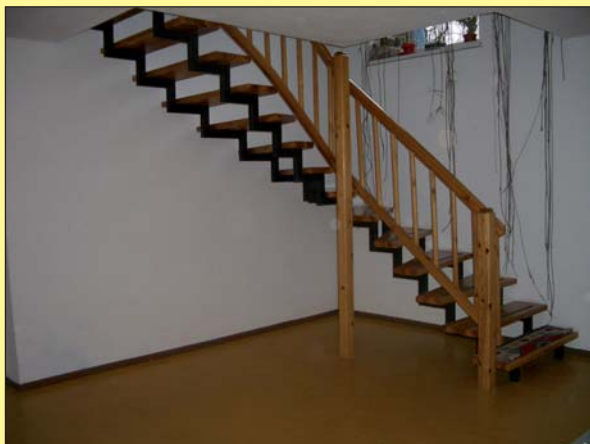
vor Sanierung - ohne Trennwand
