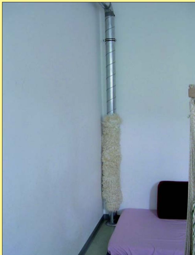
Kernbohrung mit Abluftrohr
