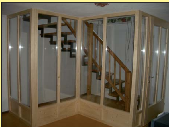
nach Sanierung - mit Trennwand
